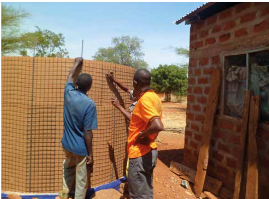
Dank der vielen Spenden werden u.a. in Tansania gerade zahlreiche neue Zisternen gebaut.
