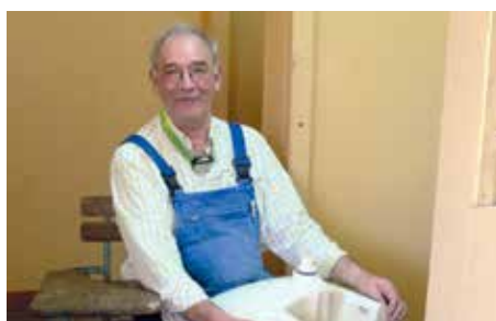
Hermann Altemeier erneuert die Sanitäranlagen.
