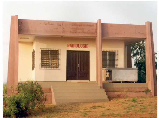
Undichte Dächer gefährden den Betrieb der Gesundheitsstation in Agbanto.
