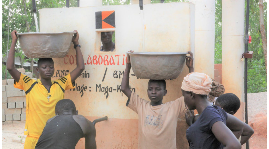
Besonders die Frauen sind erleichtert: Dank der Wasseranlage können sie ihre Zeit großzügiger bei der Feldarbeit einteilen.
