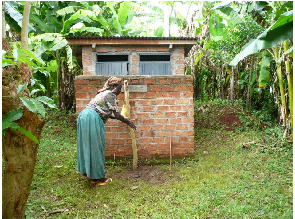
Einen großen Teil der Bauarbeiten der Latrine können die Kolpingmitglieder selbst übernehmen.
